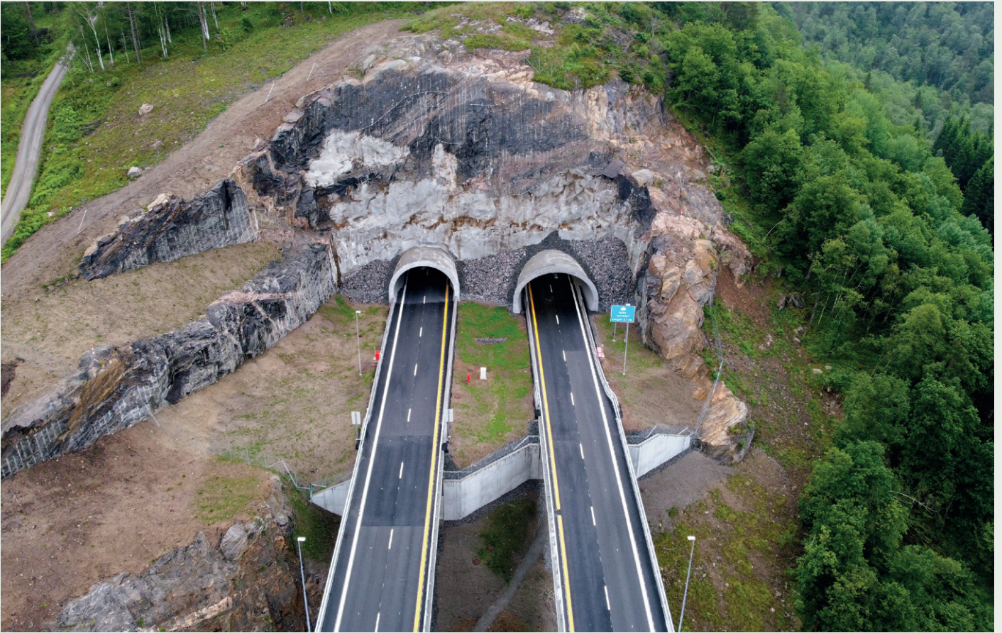
Kålstunnelen vestre løp.
