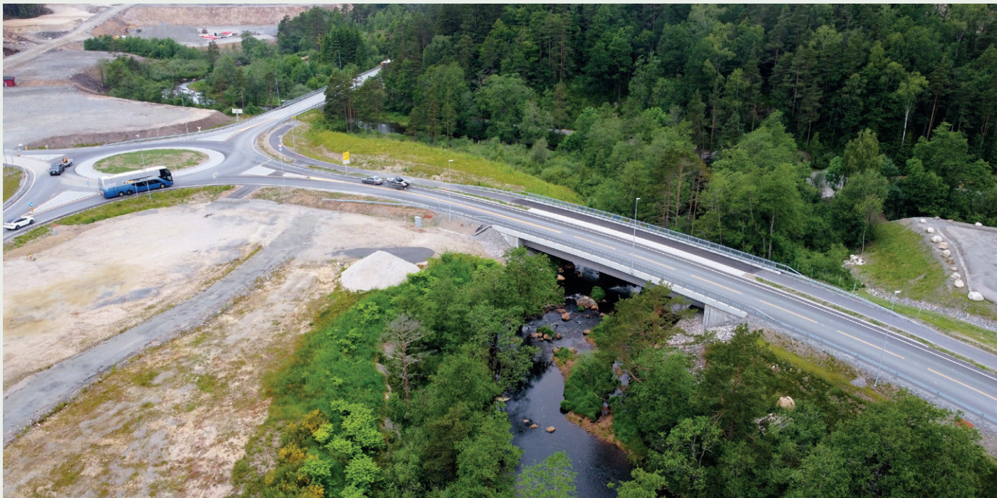
Møllerveien bru ved Herdal.
